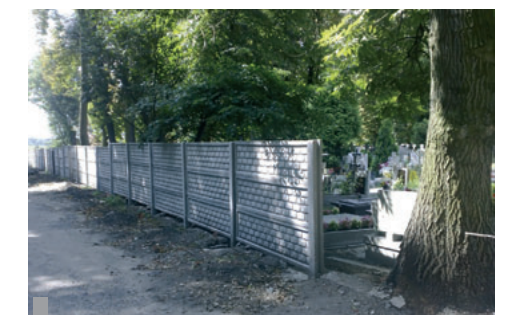
Nowe ogrodzenie cmentarza przy ul. Gorlickiej
